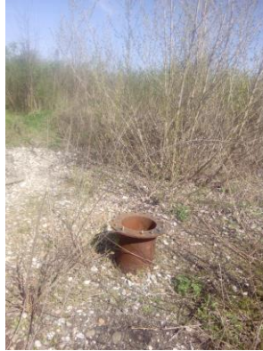
Слика 10: Геотермална бушотина (девастирана)
